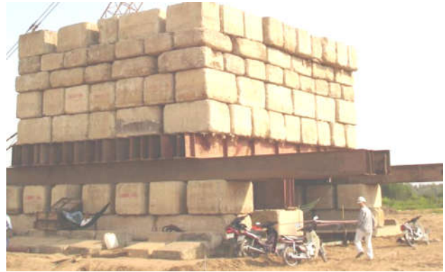
Hình 1. Hiện trường gia tải thí nghiệm nén tĩnh cọc (Nguồn: https://www.kynangxaydung.com/2020/09/thiet-ke-xay-dung-suc-chiu-tai-nen-tinh/ )
