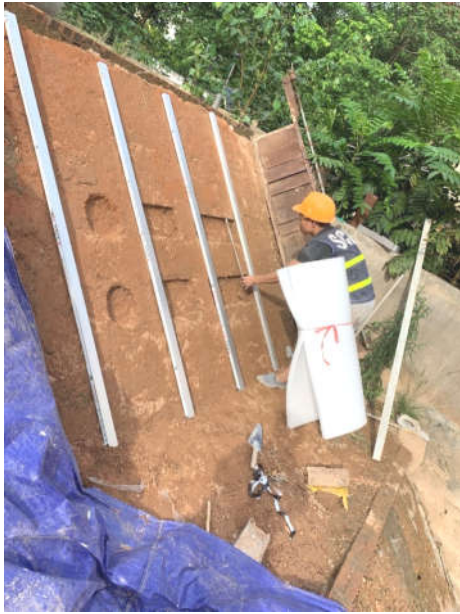
Hình 3. Quá trình xây dựng mô hình vật lý
