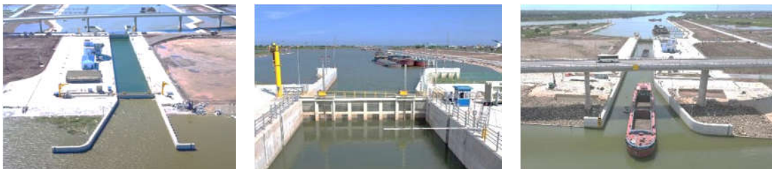
Hình 2.3. Cửa van đẩy ngang tại âu tàu Nghĩa Hưng
