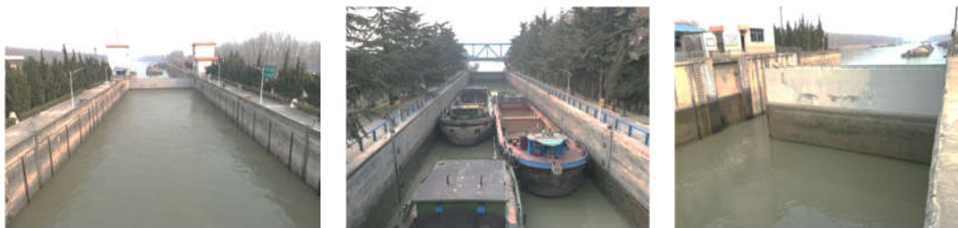
Hình 2.2. Cửa van đẩy ngang tại âu tàu Liulaojian
